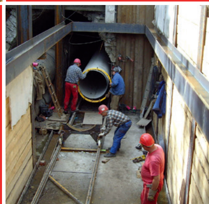
Relining und Ersatzneubau von Trinkwasserleitungen (Stahl, ZMA, DN 400 - DN 1000) im Rohrtunnel Höchst
