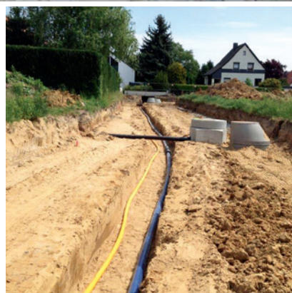
Verlegung einer Trinkwasserleitung (PE, Da 160) in Leipzig Portitz
